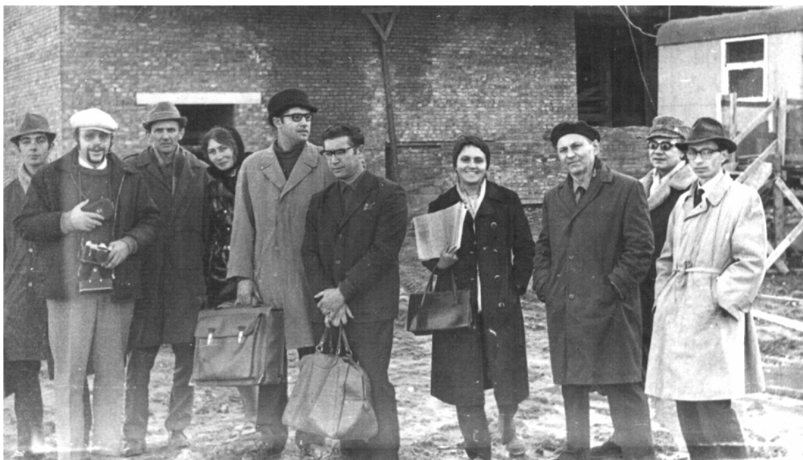
Сотрудники кафедры молекулярной физики инспектируют строительство здания НИИФ в Старом Петергофе, 1974 г.
